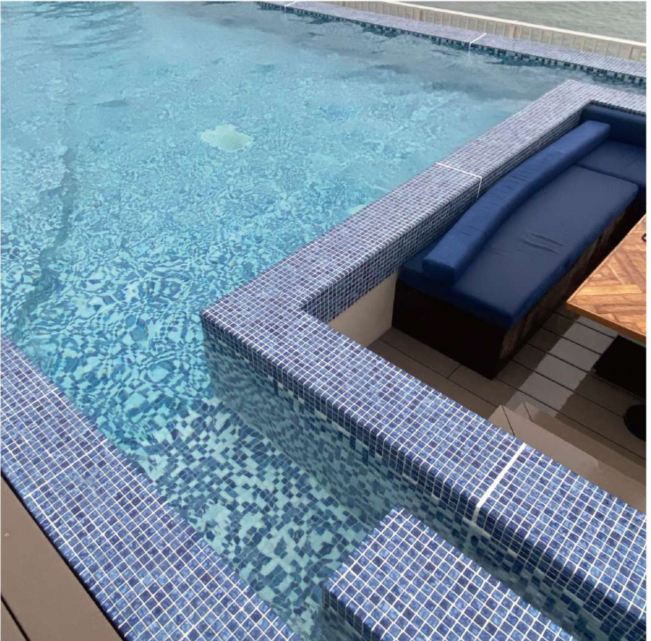
施工例：THE HARBOR TERRACE スターダスト特注 MIX S-8(30%), 9(10%), 11(60%) / 外周 S-11
